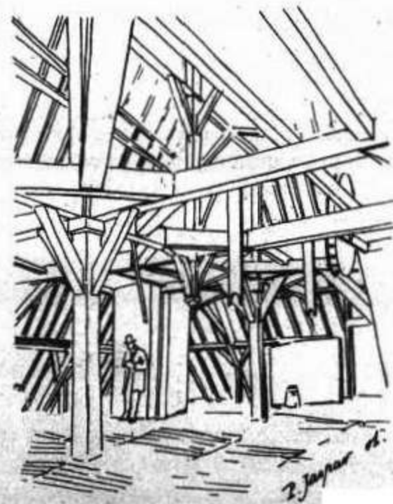
Charpente de la maison Forquin.
